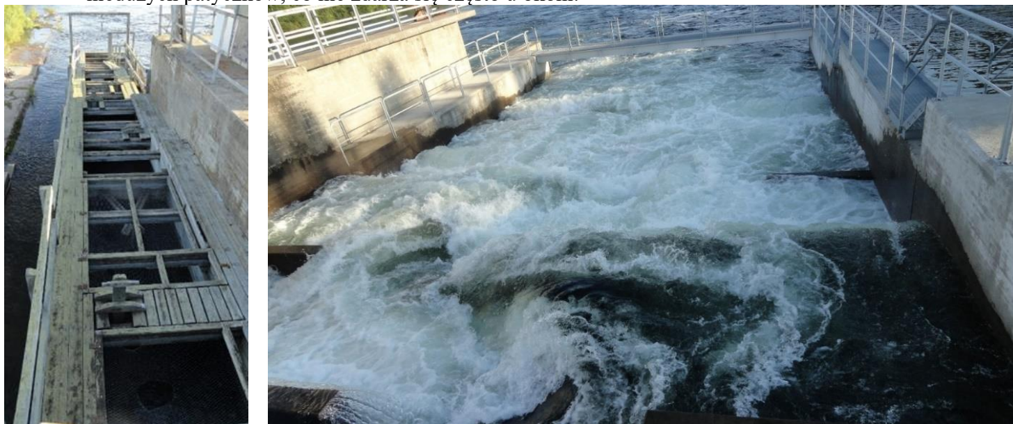
Fot. 1. Przepławki dla ryb na zaprze w Bergnäsdammen: po lewej – stara drewniana, po prawej – wybudowana w 2022 r.
